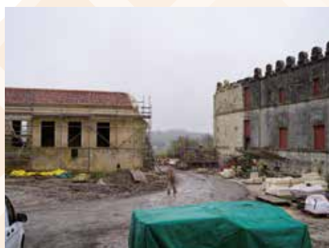
Chantier de restauration du Château de Bouteville
